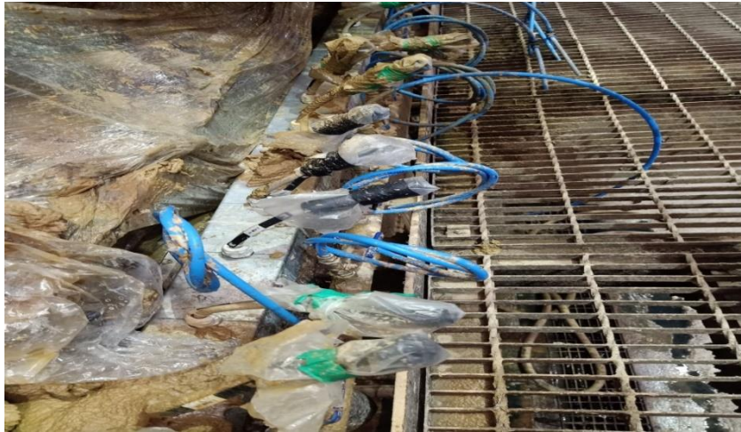
ภาพที่ 2 แสดงการติดตั้งสายสัญญาณเอาต์พุตของพีแอลซีไปหน้างาน
