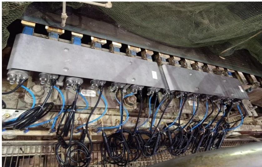
ภาพที่ 3 แสดงการติดตั้งมอดูร์ลอม
