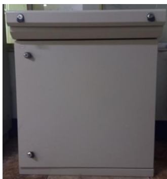
ภาพที่ 4 แสดงตู้ชุดควบคุมใบมีดรีดน้ำจากเยื่อกระดาษด้วยพีแอลซี
