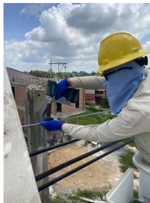
ภาพที่ 9 บล็อกจิ้งจกทดสอบปฏิบัติงานจริงโดยไม่ดับกระแสไฟฟ้า
