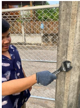
ภาพที่ 1 การใช้ประแจเลื่อนในการขันน็อตเอ็ม16
