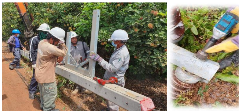
ภาพที่ 10 ทดสอบบล็อกจิ้งจกงานติดตั้งเสาไฟฟ้าใหม่(ซ้าย)งานแก้ไขเปลี่ยนลูกถ้วย (ขวา)
